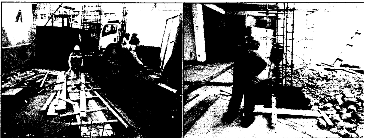
Foto N° 11 y 12: construcción de muros de ladrillo, sobrecimientos, y vaciado de zapatas en Area de Administracion reubicada.
